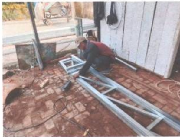
PEK. ATAP RANGKA HOLLOW DAN PENUTUP GALVALUM
