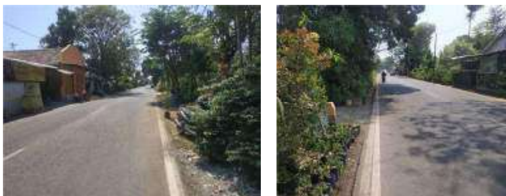
Gambar 2.8 Kondisi Jl. Slamet
